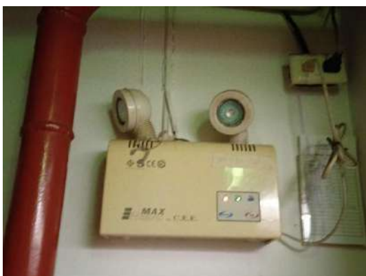
ภาพที่ 29 ไฟส่องสว่างฉุกเฉิน
